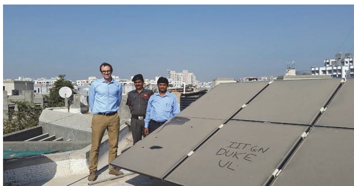
Рис. 5. Загрязнение солнечных панелей в Индии
